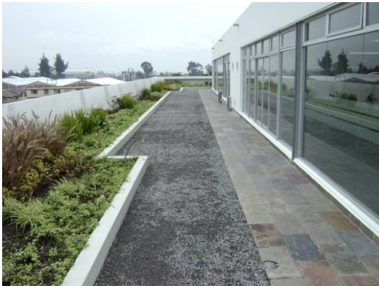
Gráfico 4.6. Superficie de captación en cubierta: vegetación y piso de grava
