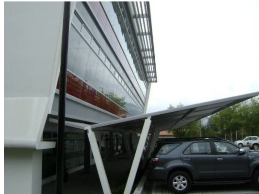
Gráfico 4.7. Superficie de captación en entrada posterior: cubierta cóncava
