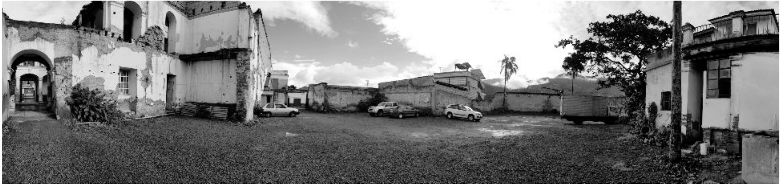
Figura 123. Exteriores casa Sr. Patricio Cárdenas Fuente: Sara Cachimuel, 2019
