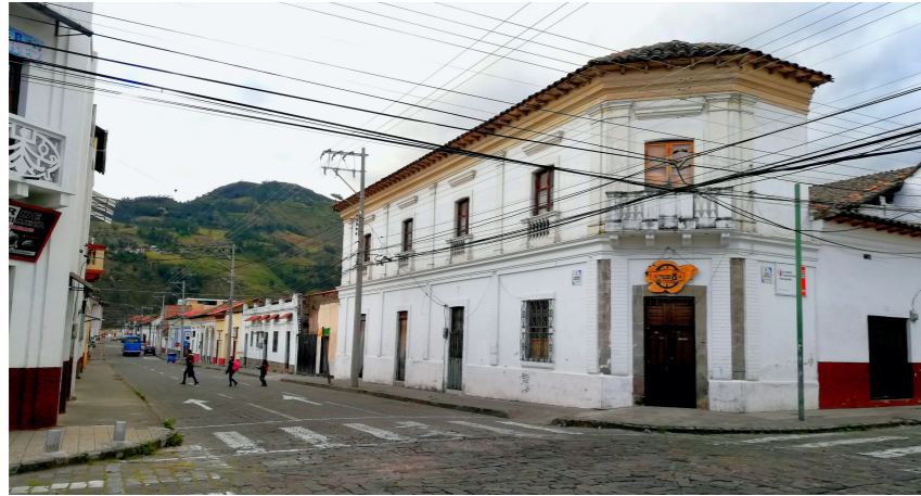
Figura 98. Vista calle Eusebio Borrero Fuente: Sara Cachimuel, 2019
