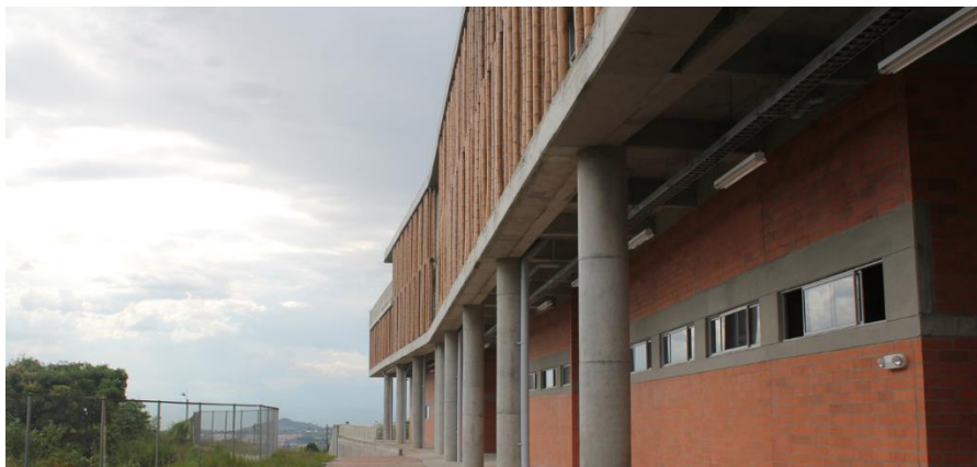
Ilustración 24 Referente 2, fachada principal, materialidad
