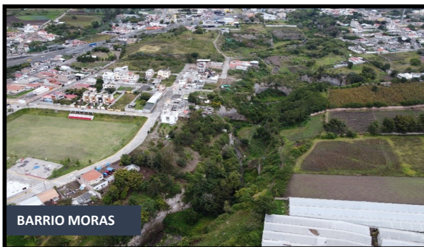
Figura 25. Vista aérea del sector de estudio, donde se observan características relevantes, como bordes naturales, ejes viales y quebradas naturales. Fuente: Elaboración propia, 2023
