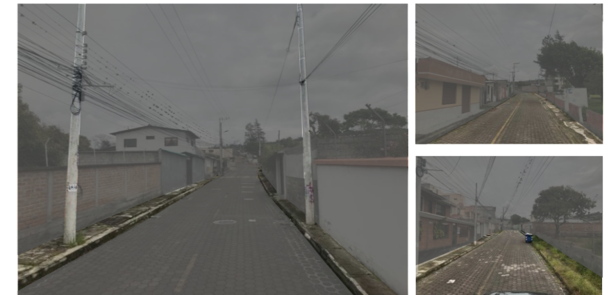
Figura 48. Percepción visual del estado de las vías. Fuente: Elaboración propia, 2023
