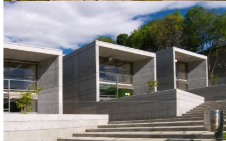
Figura 17. Cajas de contenedores fabricadas en concreto vaciado dispuestas de manera escalonada. Fuente: Vera J, 2007
