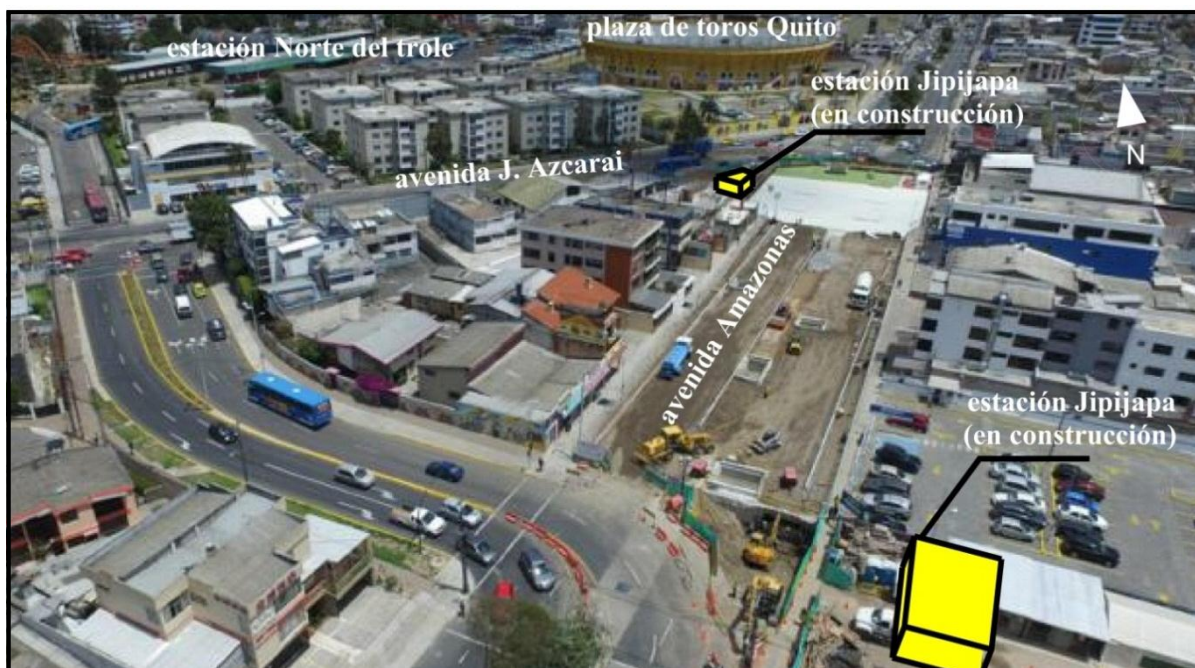
Figura 21: Construcción de la estación Jipijapa
