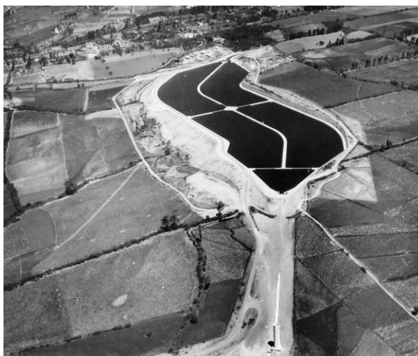
Reservorio de Cumbayá EEQ año 1961. Fuente: Santiago Jaramillo/ http://www.panoramio.com/photo/59126392
