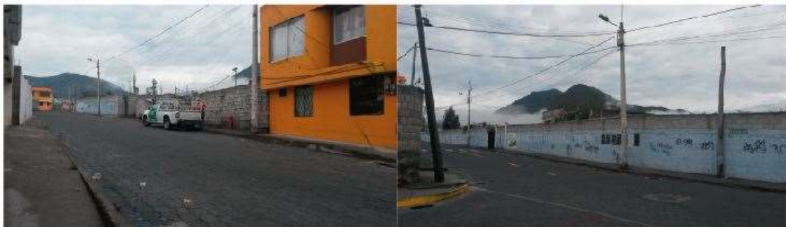
Figura 64: Construcciones del Sector
