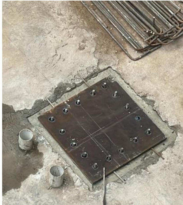
Anexo 18: Placa Metálica (conexión cimentación estructura).
