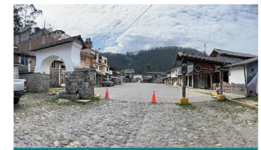
Figura 81 zona elementos antrópicos.
