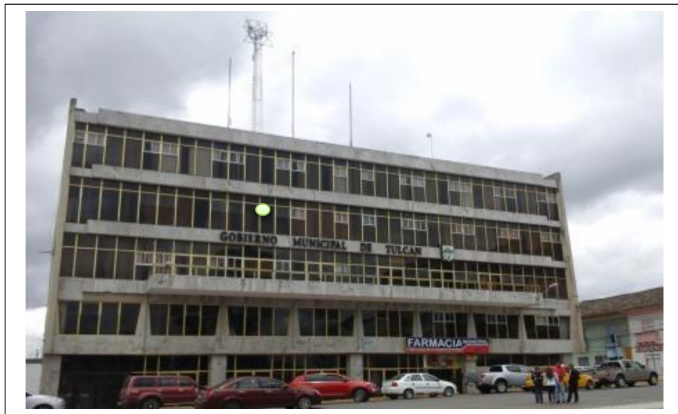
Figura 64. Fotografía Edificio del Municipio de la Ciudad de Tulcán, Ubicación del Centro de Datos
