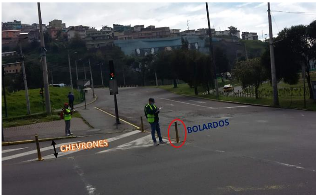
Figura 18: Señalización horizontal Av. Velasco Ibarra (Norte-Sur)
