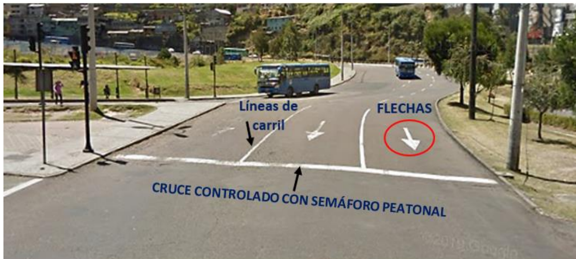
Figura 15: Señalización horizontal Av. Pichincha
