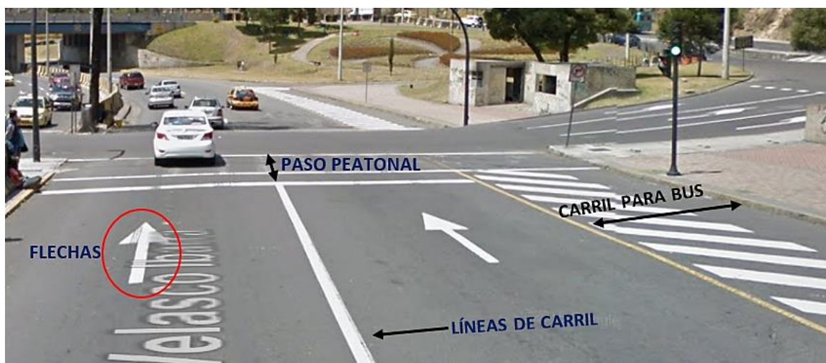
Figura 16: Señalización horizontal Av. Velasco Ibarra (Sur-Norte)
