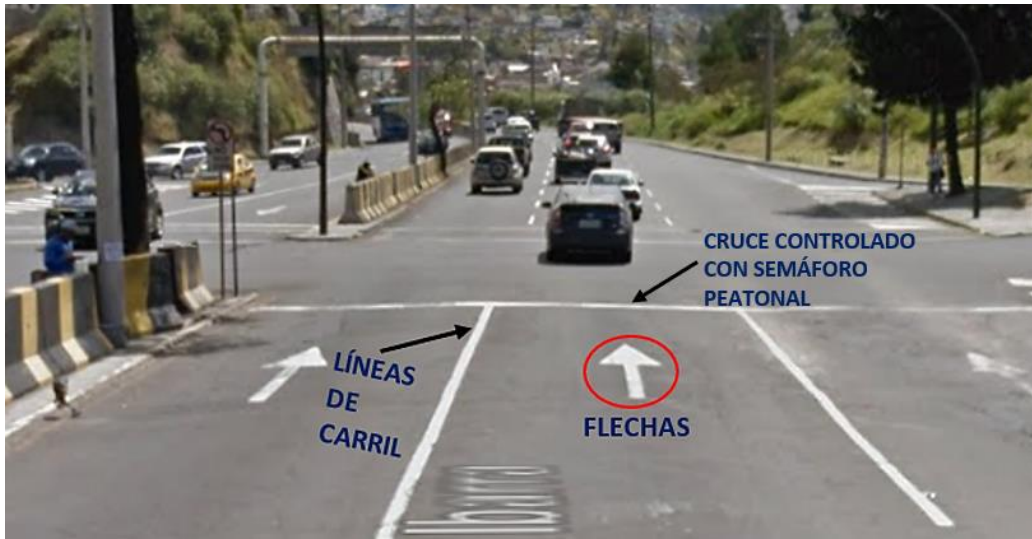
Figura 17: Señalización horizontal Av. Velasco Ibarra (Norte-Sur)
