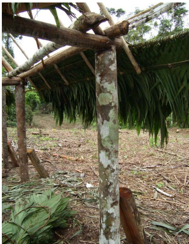
Anexo 14 Empalme, estructura interna
