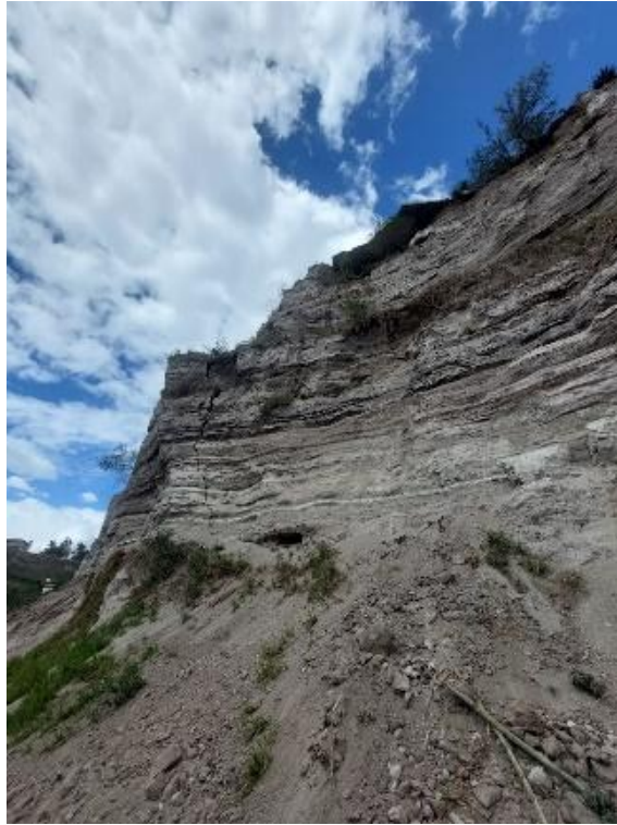
Ilustración 15.- Talud de estudio con los diferentes estratos visibles.
