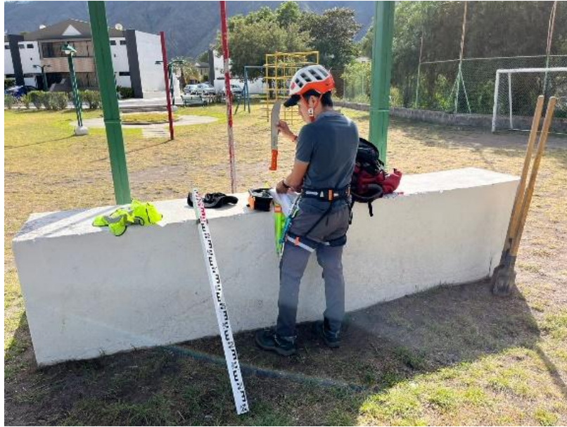
Ilustración 11.- Accesorios para toma de muestras y descendimiento del talud.
