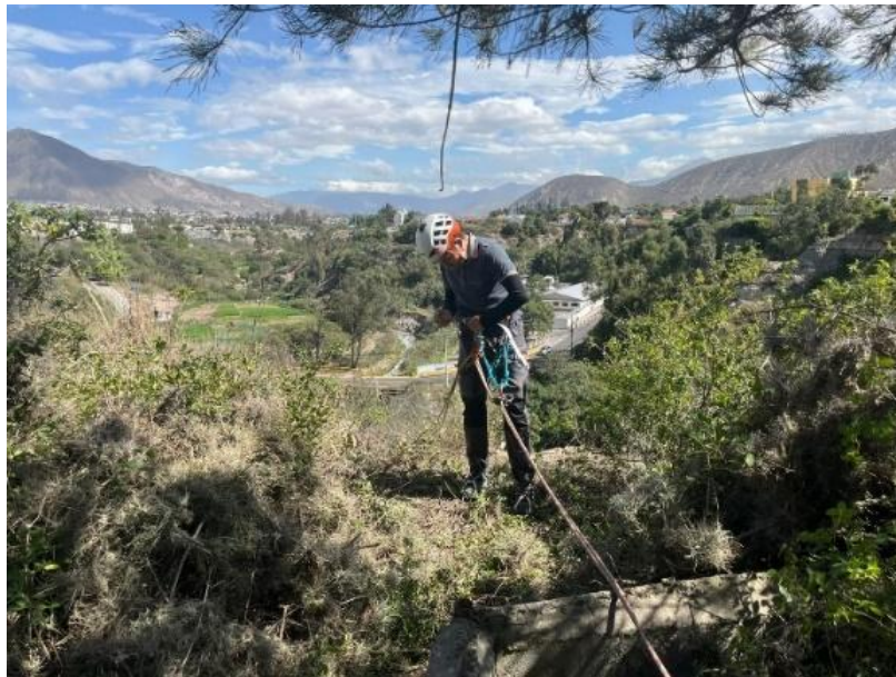
Ilustración 12.- Instalación de cuerda para el descendimiento del talud, realizado por personal calificado para este proceso.
