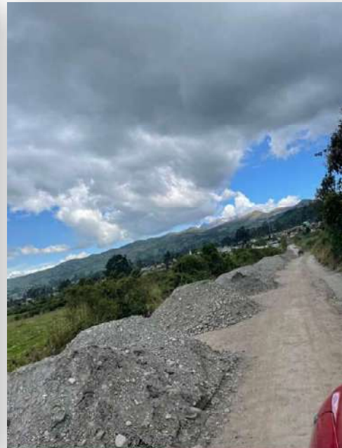
Ilustración 26 Proceso de lastrado de la via
