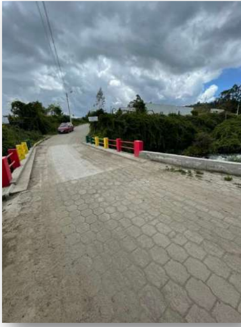
Ilustración 33 Puente con mantenimiento óptimo
