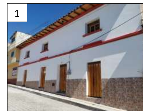
Figura 84: Edificación dureza alta 1 Fuente: Elaboración propia
