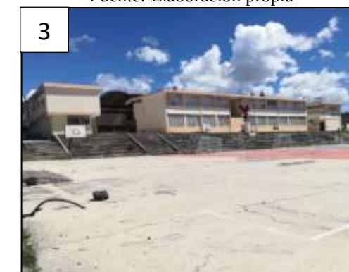
Figura 86: Edificación dureza media Fuente: Elaboración propia
