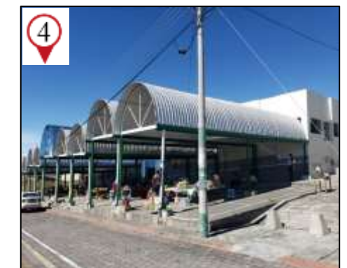
Figura 54: Mercado de Mira Fuente: Elaboración propia
