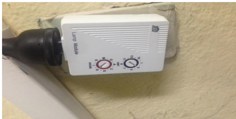
Ilustración 4.4: Instalación Modulo de lámpara LM465
