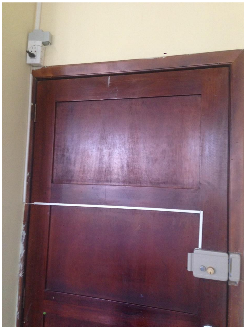
Ilustración 4.6: Instalación cerradura eléctrica y cableado
