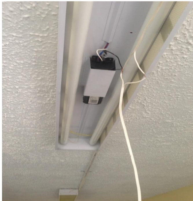
Ilustración 4.1: Instalación de luces en la Escuela de Sistemas
