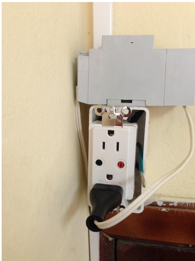
Ilustración 4.7: Cerradura eléctrica y transformador
