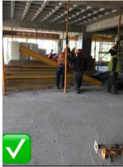
Ilustración 46.- Base sólida y antideslizante para almacenamiento de material.
