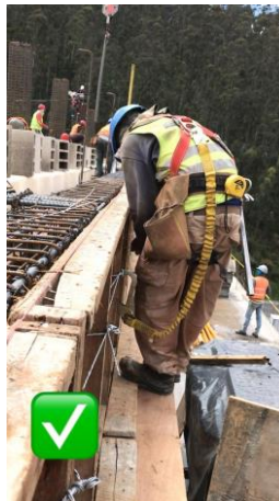
Ilustración 19.- Verificación del uso de equipo de protección personal para trabajos en alturas.
