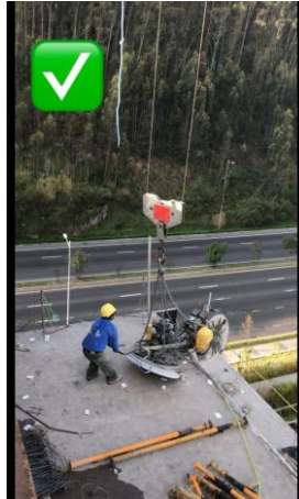
Ilustración 35.- Transporte de objetos móviles de manera segura.
