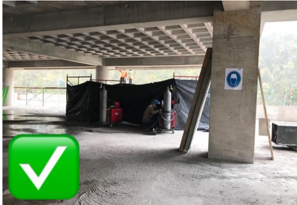
Ilustración 41.- Delimitación de la zona de trabajo.
