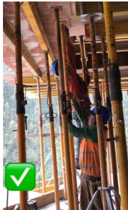
Ilustración 51.- Revisión del apuntalamiento antes de la fundición.
