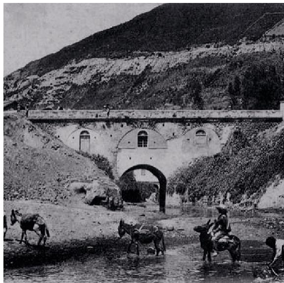
FIGURA 2: Puente sobre el río (Quito 360,2020)
