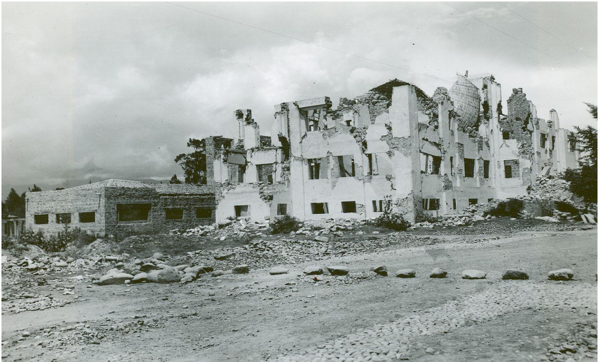
Figura 1-5 Hospital arruinado producto del terremoto de Ambato del 5 de agosto de 1949 Fuente: Lewis, 1949
