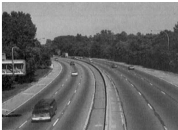
Figura 1. Ejemplo de Nivel de Servicio A. Libre circulación. Tomado de: Highway Capacity Manual (HCM) (p. 130) por Transportation Research Board, 1994, The National Academies Press.
