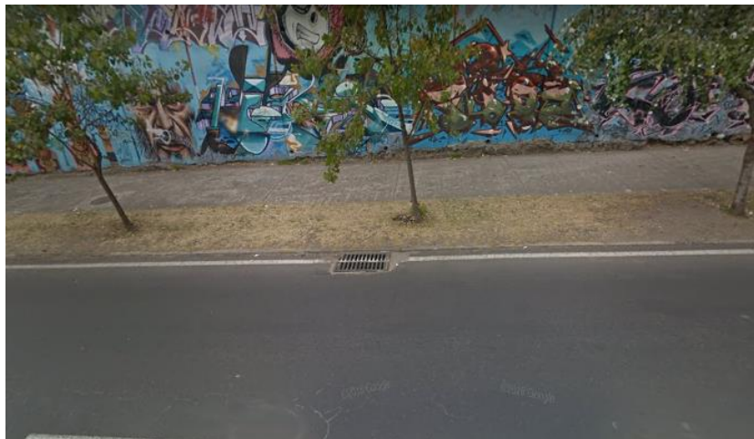
Figura 34. Alcantarilla en la Avenida Mariscal Sucre. Elaborado por: José Jaramillo y Ángel Espinel
