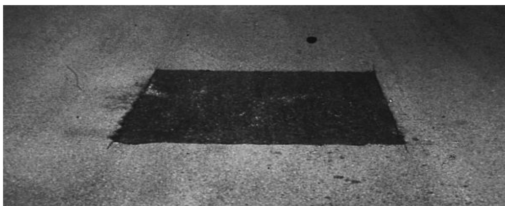
Figura 2.7 Ejemplo de parcheo de baja severidad
