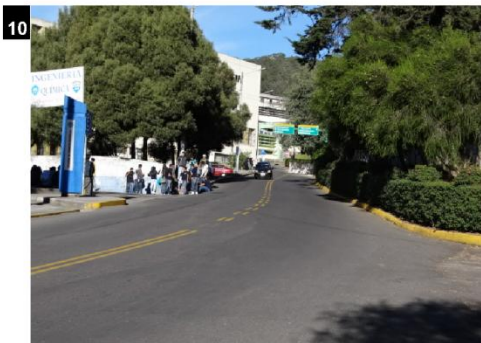
En algunos lugares no existe aceras dentro del Campus U.C.E. Acceso Leyton.
