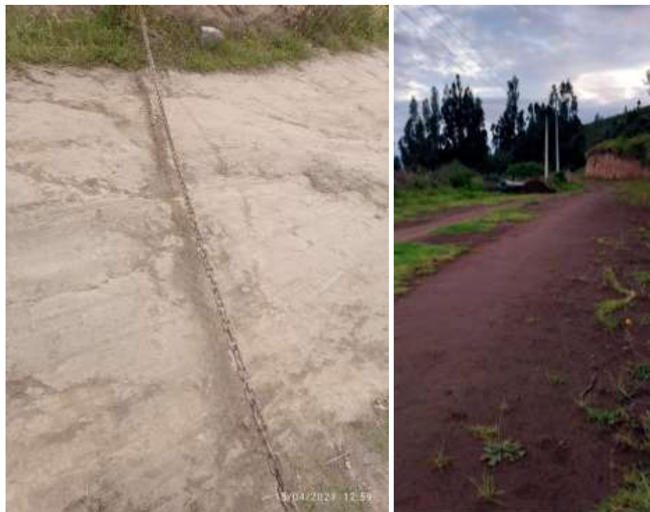
Figura 21: Acceso de Sitio Carrera
