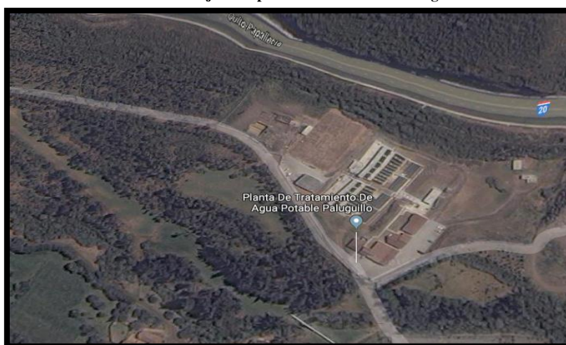
Ilustración 3: Área de trabajo de la planta de Tratamiento de agua PALUGUILLO
