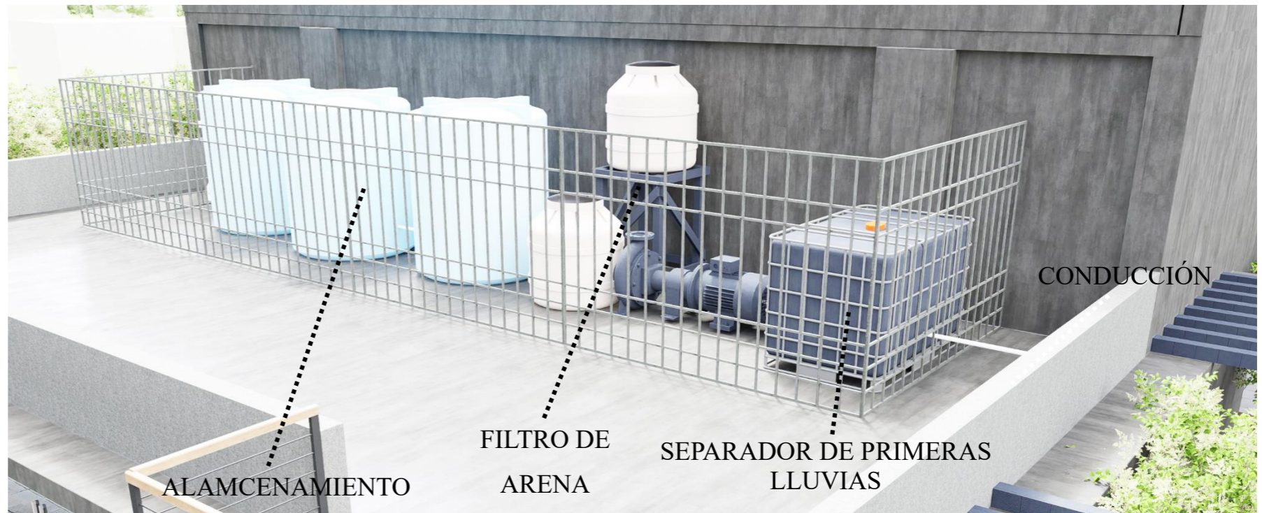
Figura 204: Sistema de recolección de agua lluvia. Fuente: Autoría propia Herrera S. – Marroquín J.
