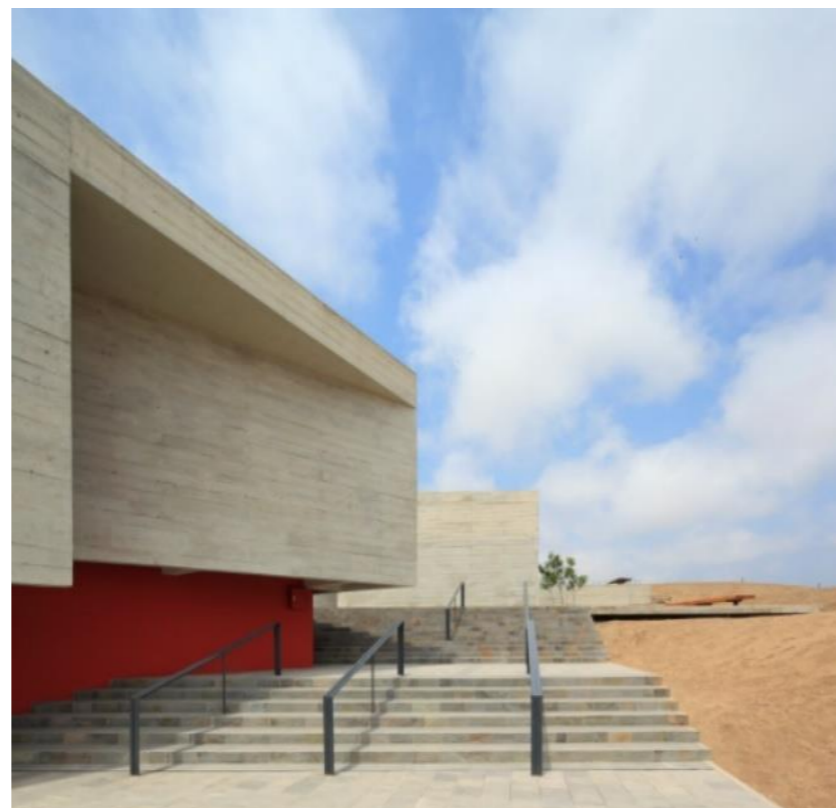
Figura 63: Rampa museo de sitio Pachacamac.
