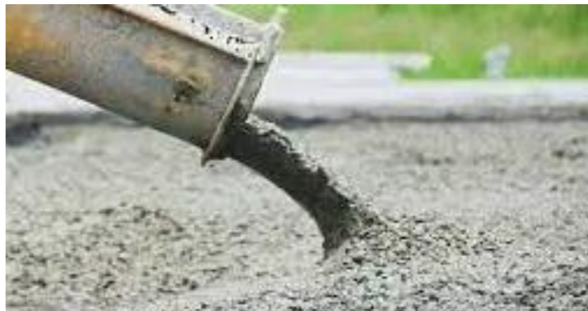
Figura 30: Vertido de hormigón. Fuente: Manual de sostenibilidad.
