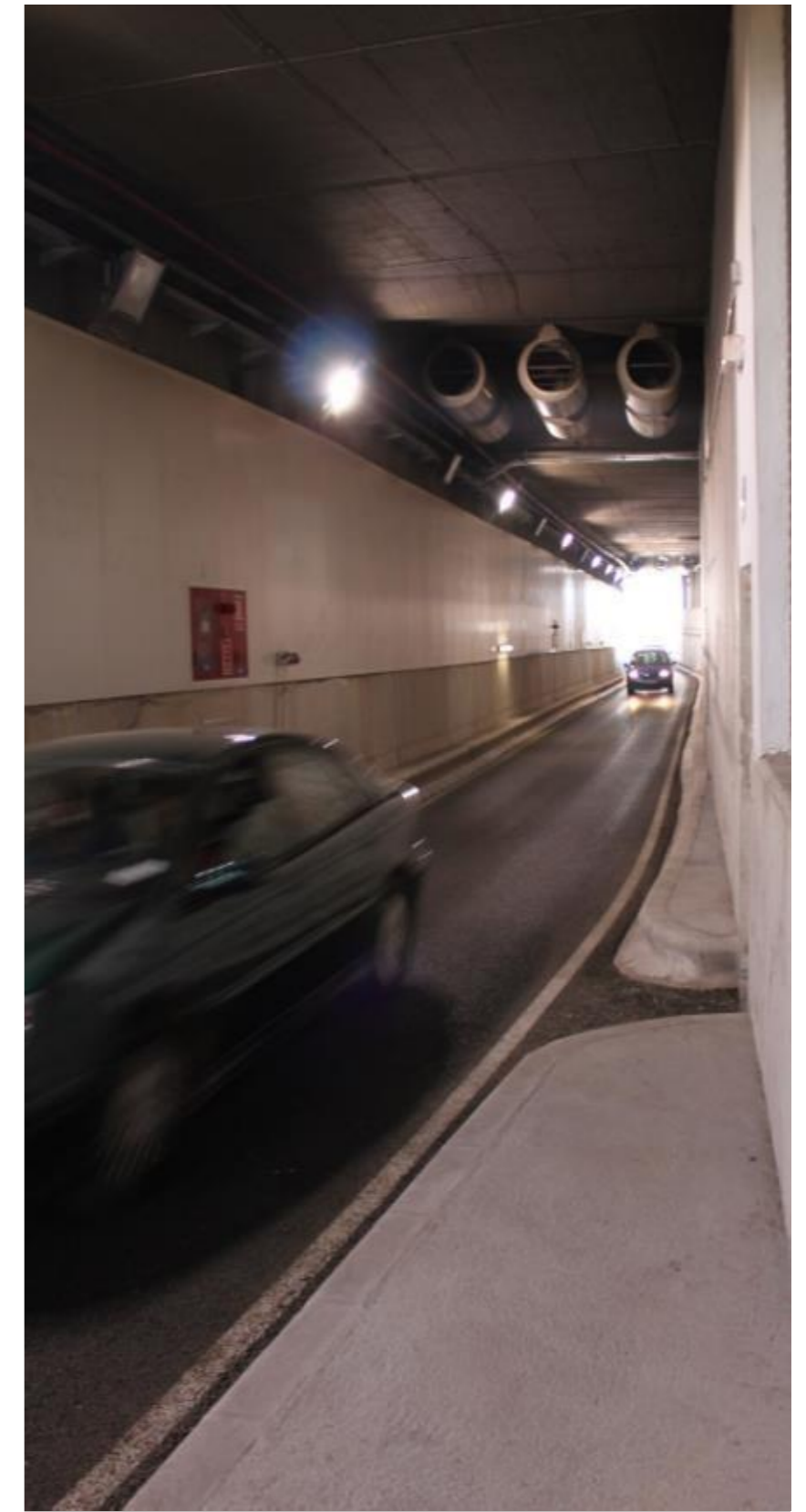
Figura 46: Acceso vehicular subterráneo.
