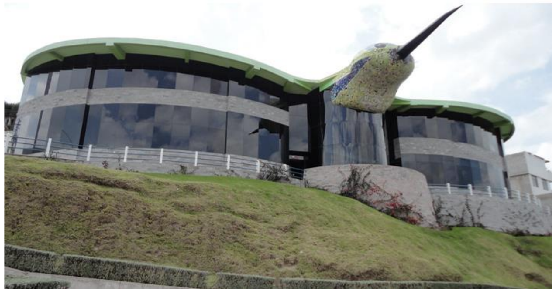
Figura 65: Vista hacia la fachada principal acristalada del Kinti Wasi.
