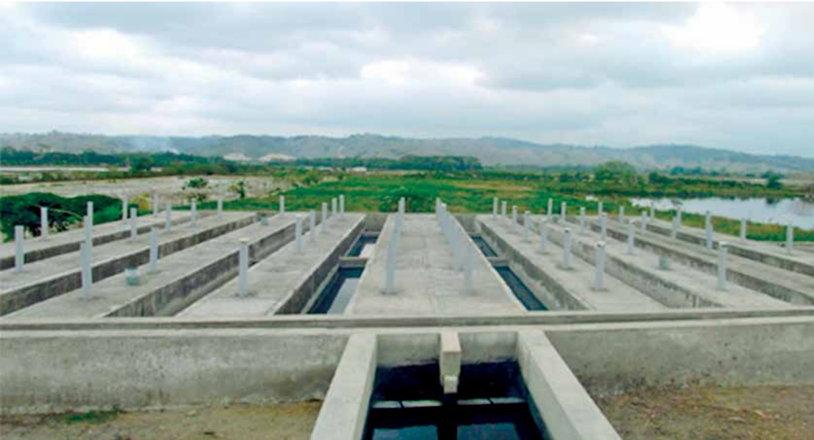
Tanque tipo INHOOF y áreas de pantano de la PTAR de Atacames
