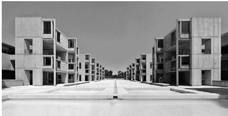
Ilustración 54 Vista del Instituto Salk (Tomado de plataforma arquitectura)
