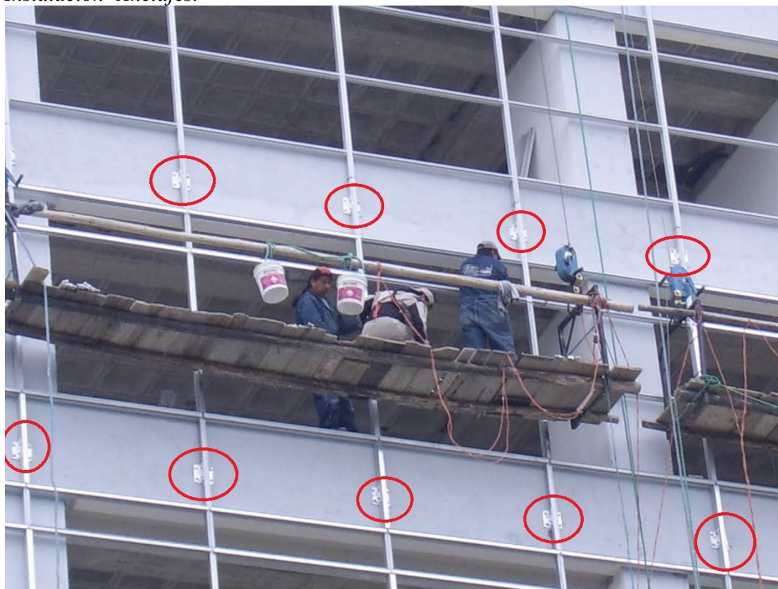
Ilustración 26 Instalación- Anclajes.
