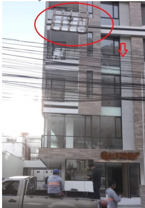
Ilustración 32 Desmontaje Estructuras Auxiliares - Recolección.
