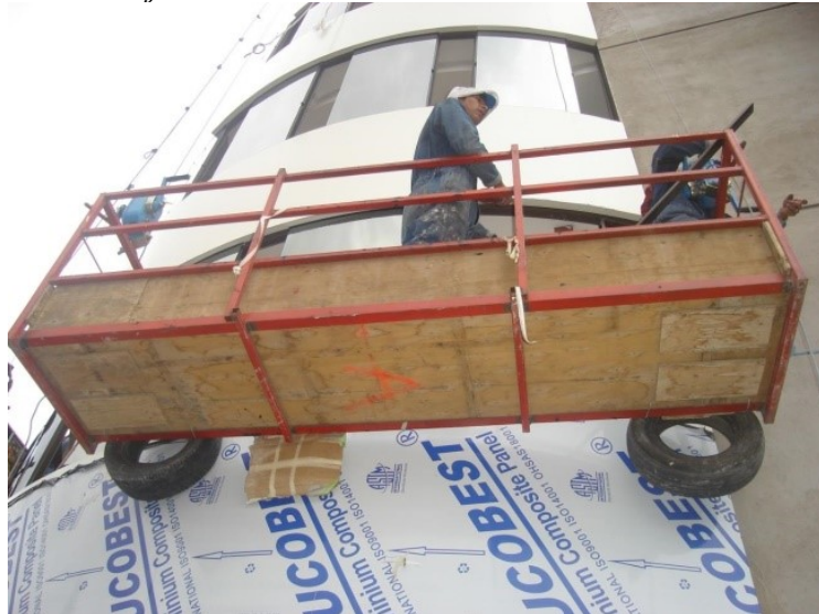
Ilustración 31 Desmontaje Estructuras Auxiliares - Desarmado.
