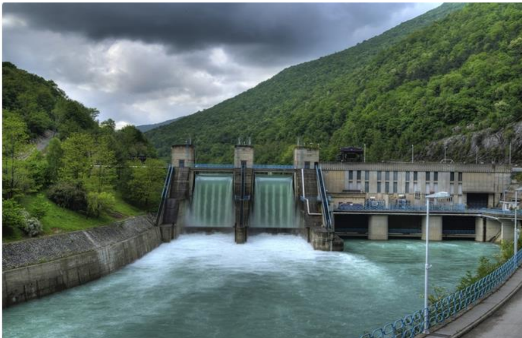
Ilustración 10: Central hidroeléctrica de Media Presión
