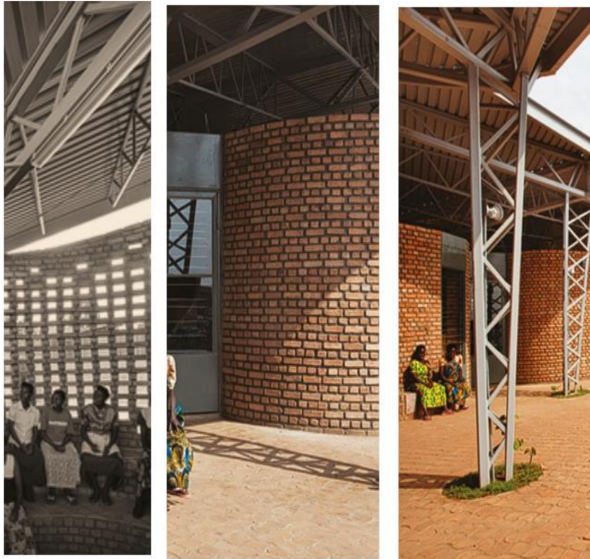
Ilustración 44 Sistema constructivo utilizado Fuente: Sharon Davis Design
