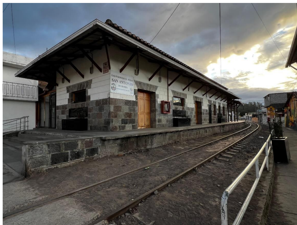
Ilustración 59 Estación de San Antonio de Ibarra
