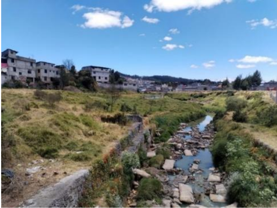
Figura 14. Zona de intervención 3, acumulación de escombros y basura, vegetación degradada
