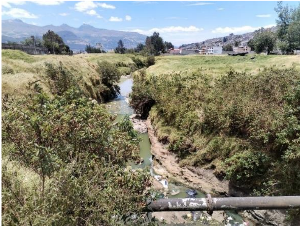
Figura 7. Zona de intervención 1, cruce de conexiones de agua potable, acumulación de basura y sedimentos
