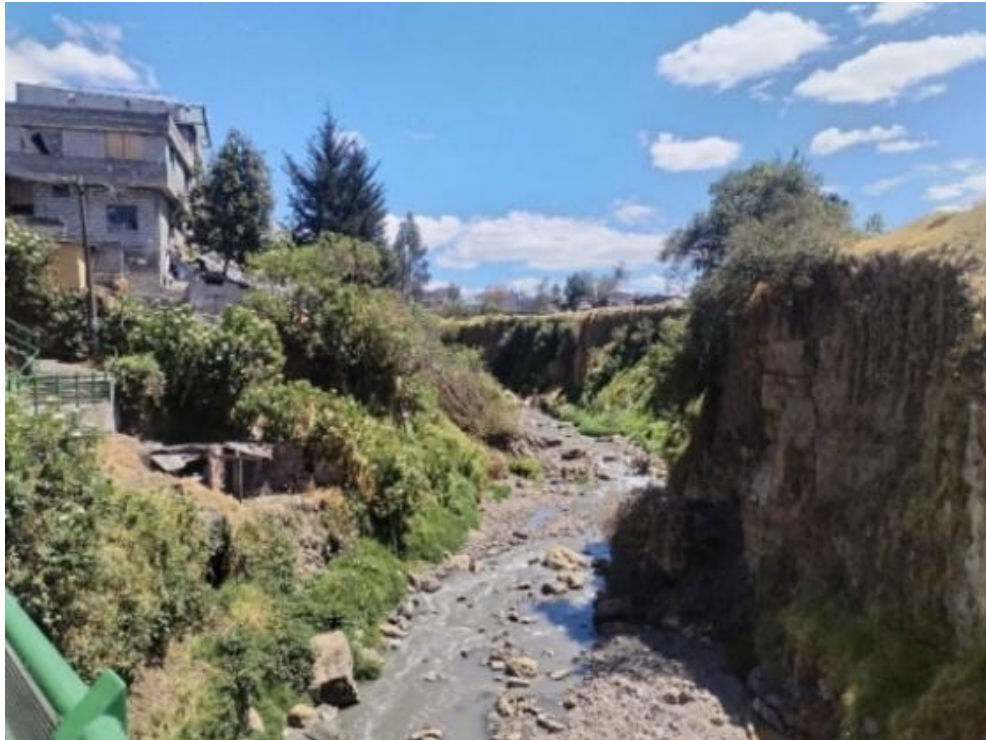
Figura 12. Zona de intervención 2, erosión de taludes vegetación degradada Fuente: Elaboración propia, 2024
