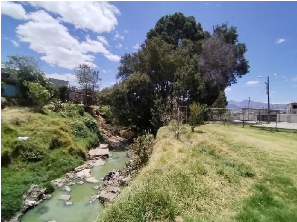
Figura 16. Zona de intervención 3, desprendimiento de taludes, vegetación degradada, acumulación de escombros Fuente: Elaboración propia, 2024
