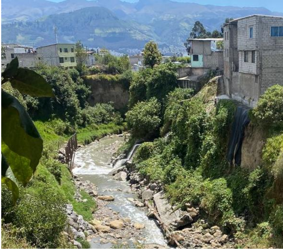
Figura 10. Zona de intervención 2, riesgo de colapso de viviendas por erosión de taludes, descargas ilegales de aguas servidas Fuente: Elaboración propia, 2024
