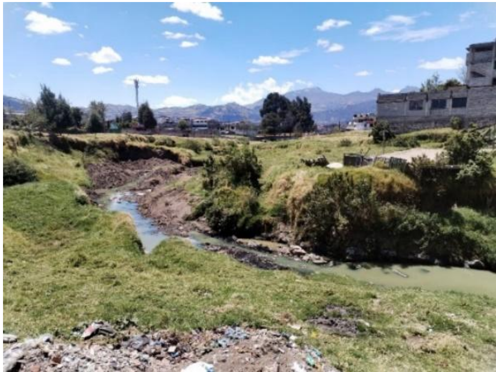
Figura 19. Zona de intervención 4, desprendimiento de taludes por erosión, vegetación degradada Fuente: Elaboración propia, 2024
