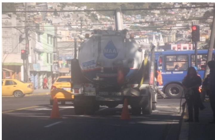
Foto 16: Cambión de la EMAAP haciendo trabajos de limpieza de alcantarillas al sur de la ciudad
