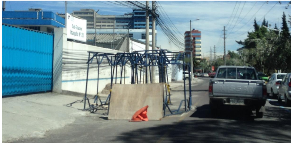
Foto 19: Material en media vía en la calle Japón
