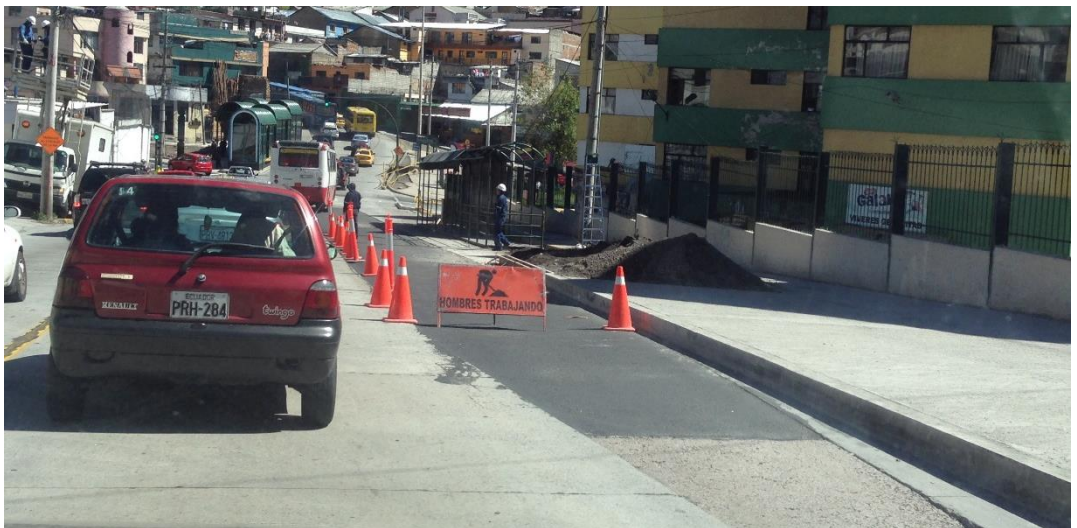
Foto 18: Reasfaltado de la Av. Occidental
