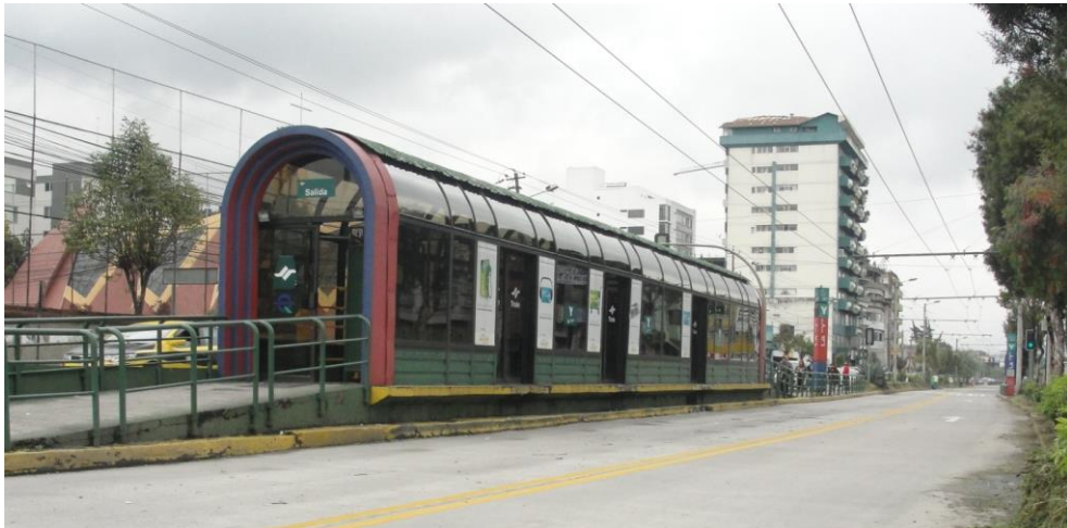
Foto 30: Estación del corredor Metrobus-Q Trolebús “La Y”
