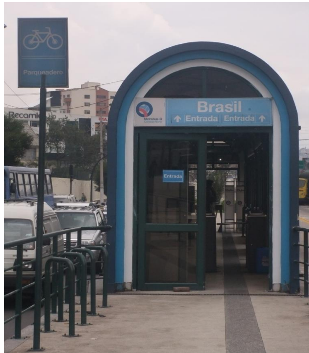
Foto 32: Entrada a la estación
