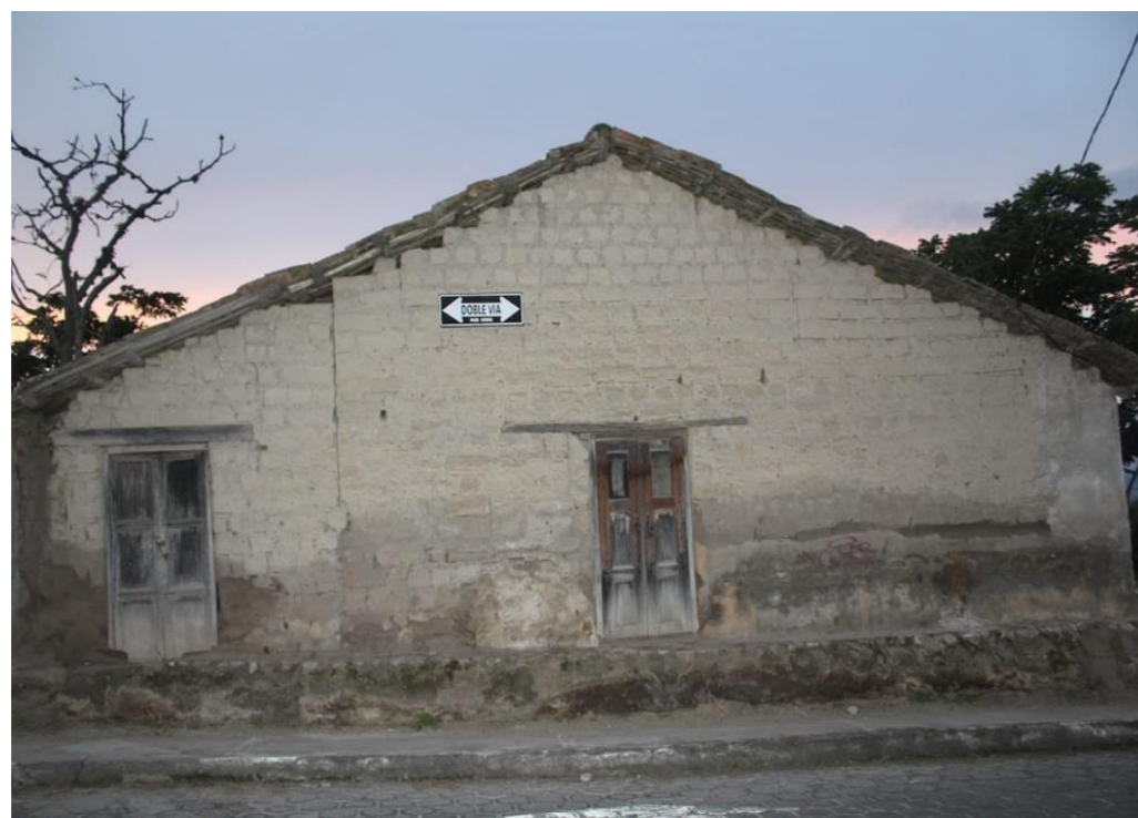
Figura 66: Vivienda de adobe Fuente: Elaboración propia
