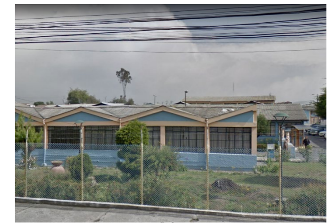
Figura 93: Fachada (cubierta metálica con eternit) Fuente: Daniel Ramón, 2015
