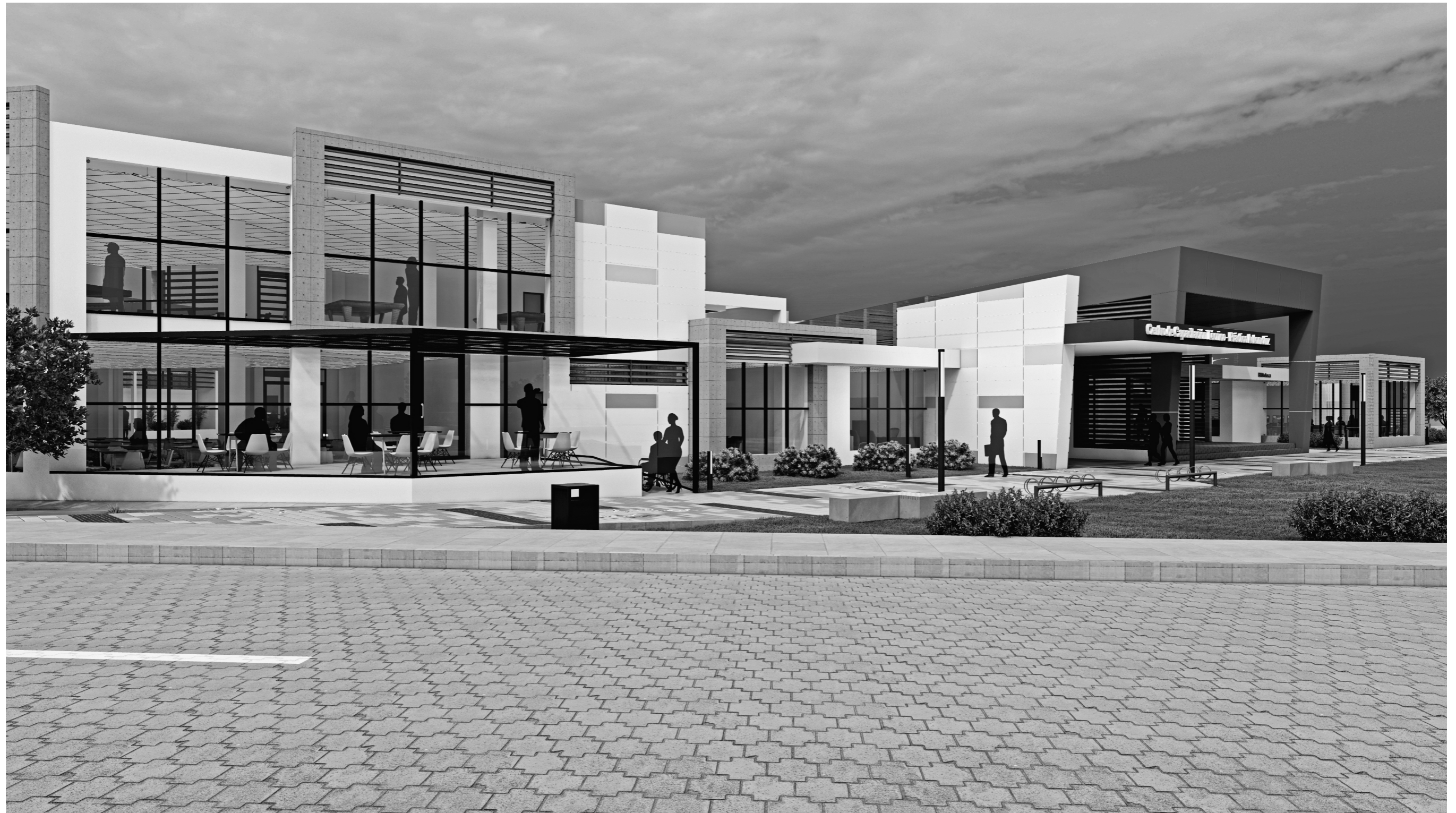
Figura 163: Vista exterior 2 de la edificación Fuente: Marlon Hurtado
