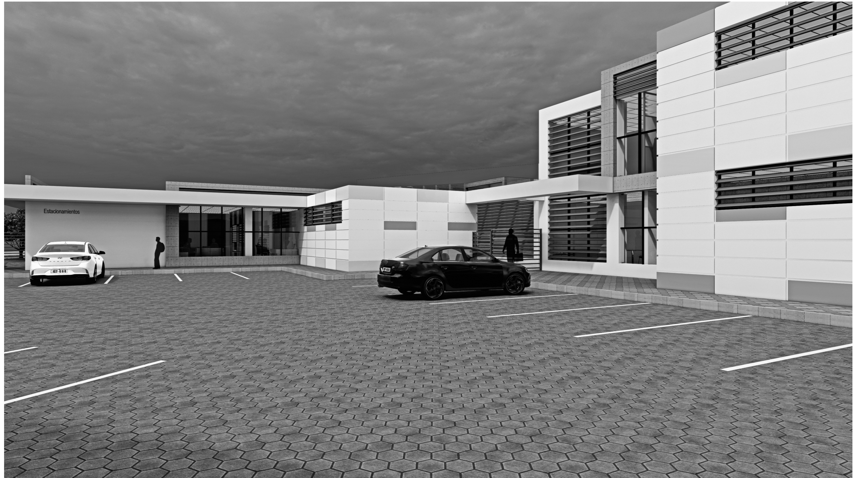
Figura 167: Vista exterior 6 de la edificación Fuente: Marlon Hurtado
