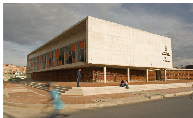
Figura 44: Ingreso al colegio Fuente: https://www.plataformaarquitectura.cl/cl/02-12344/colegio-gerardo-molina-giancarlo-mazzanti
