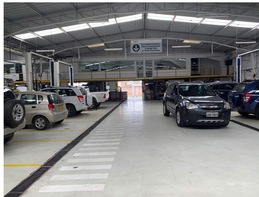
Figura 107: Vista interna taller de mecánica IMBAUTO Fuente: Marlon Hurtado
