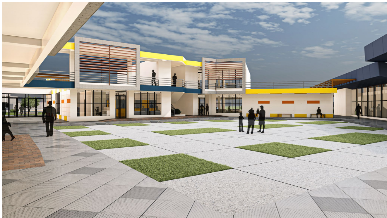
Figura 172: Vista exterior - interior 3 de la edificación Fuente: Marlon Hurtado
