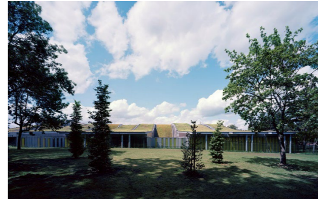
Figura 75: Descenso de cubierta hacia el parque Fuente: https://www.plataformaarquitectura.cl/cl/02-206166/escuela-secundaria-marcel-sembat-archi5
