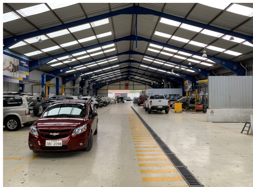
Figura 105: Vista interna taller de colisión (enderezada y pintura) IMBAUTO Fuente: Marlon Hurtado
