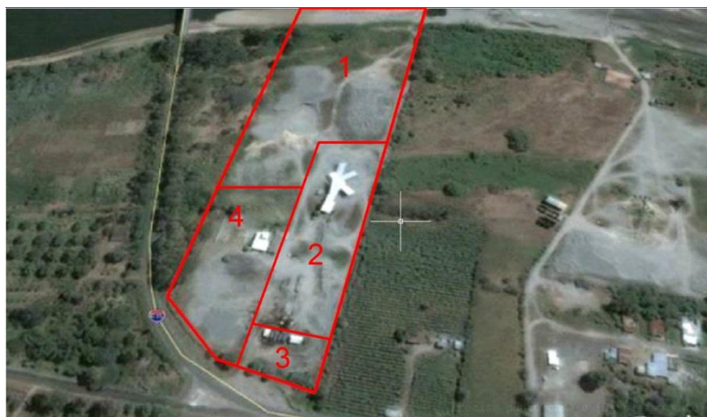
Imagen Nro. 1 Vista área de la planta asfáltica
