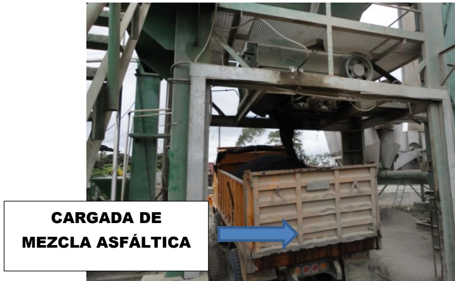
Imagen No 12 Transporte de mezcla asfáltica Fuente: Trabajo de campo
