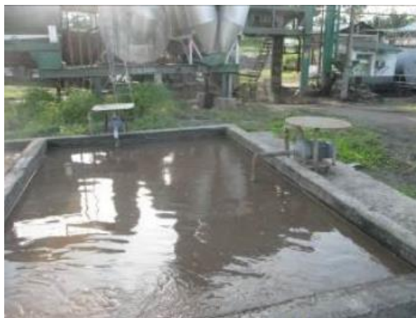
Imagen No 10 piscina de recolección de polvos por vía húmeda
