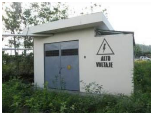
Imagen No 16 Cuarto de generación eléctrica
