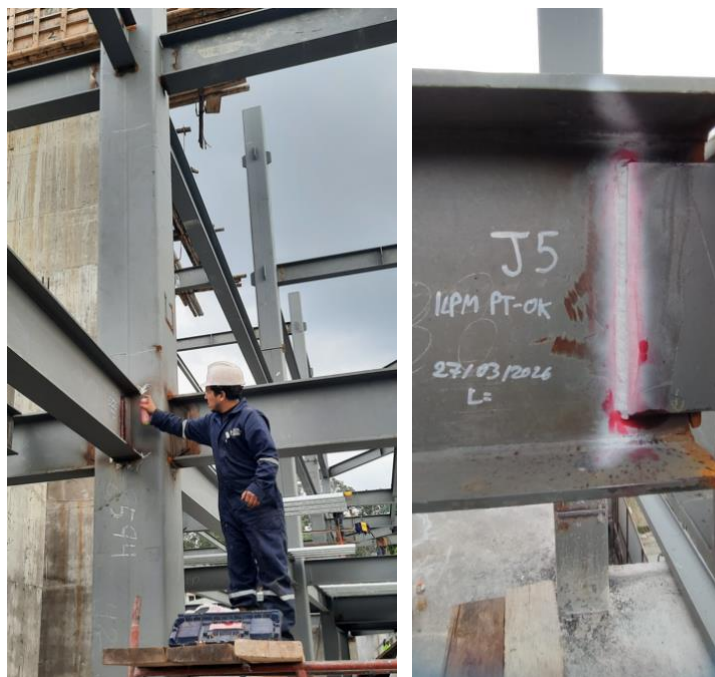
Figura 2: Ensayo no destructivo superficial Fuente: Elaboración propia
