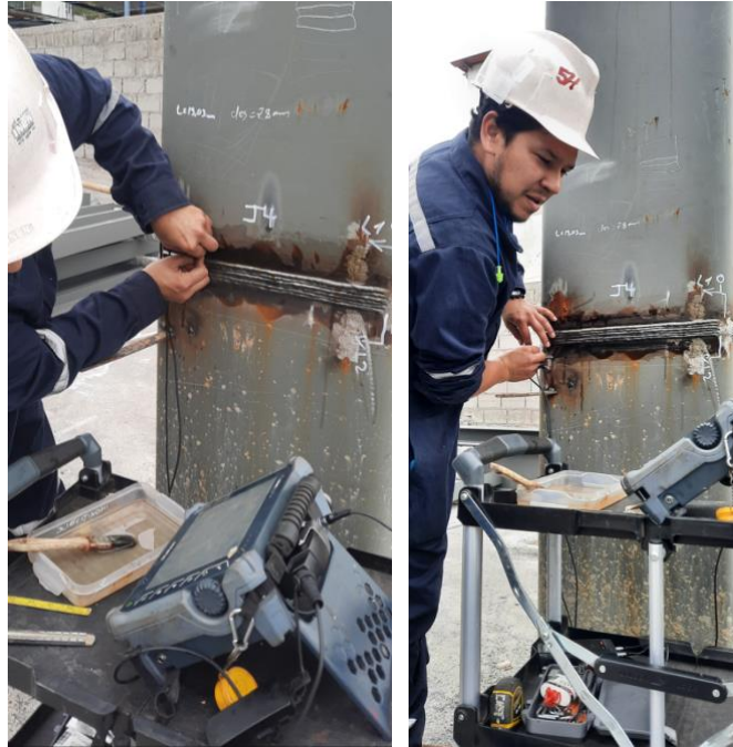
Figura 3: Ensayo no destructivo volumétrico Fuente: Elaboración propia
