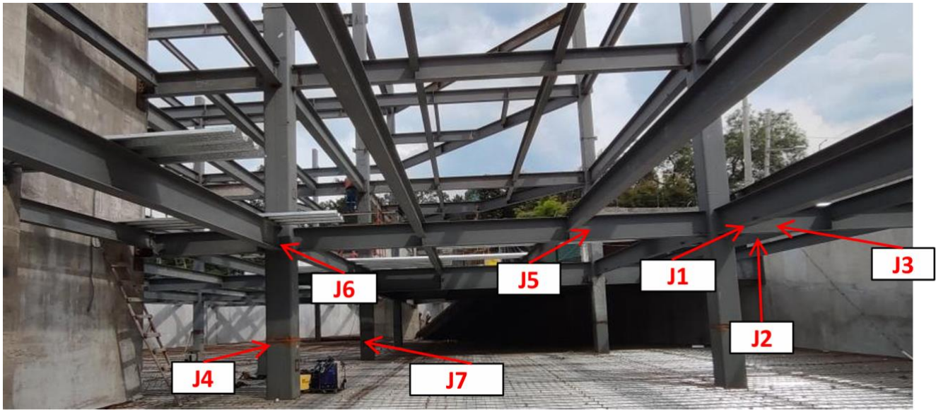
Fotografía(s) de la(s) junta(s) o elemento(s) inspeccionado(s) [18]
