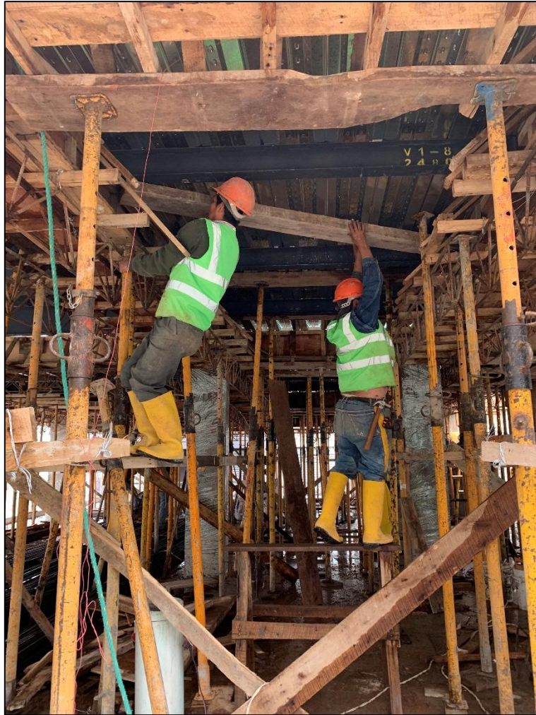
Posible caída y golpes con encofrados. Elaborado por: Fernández Peralta Jorge Luis
