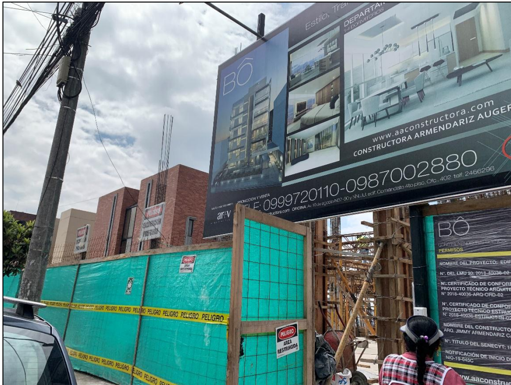
Cerramiento provisional y bandas de peligro colocado por la constructora. Elaborado por: Fernández Peralta Jorge Luis
