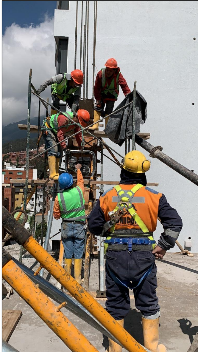
EPP para cada trabajador y seguridad para trabajo en alturas (arnés). Elaborado por: Fernández Peralta Jorge Luis
