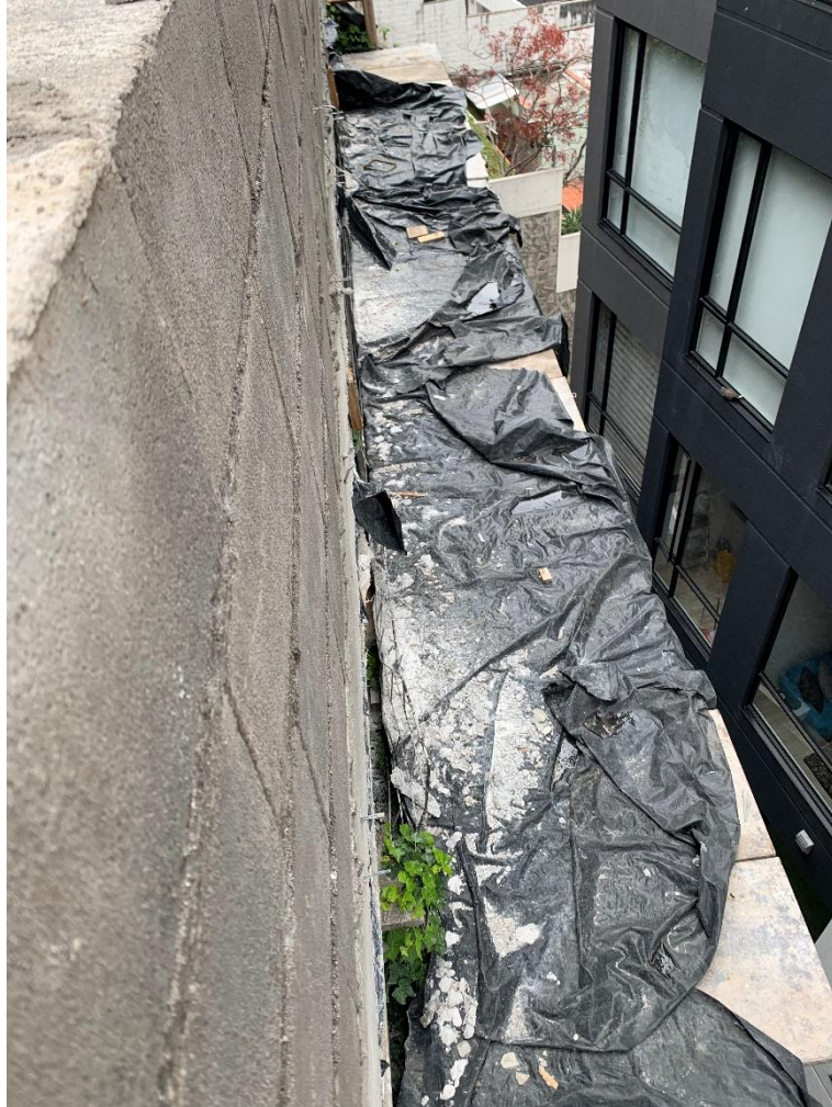
Protección para las construcciones aledañas. Elaborado por: Fernández Peralta Jorge Luis
