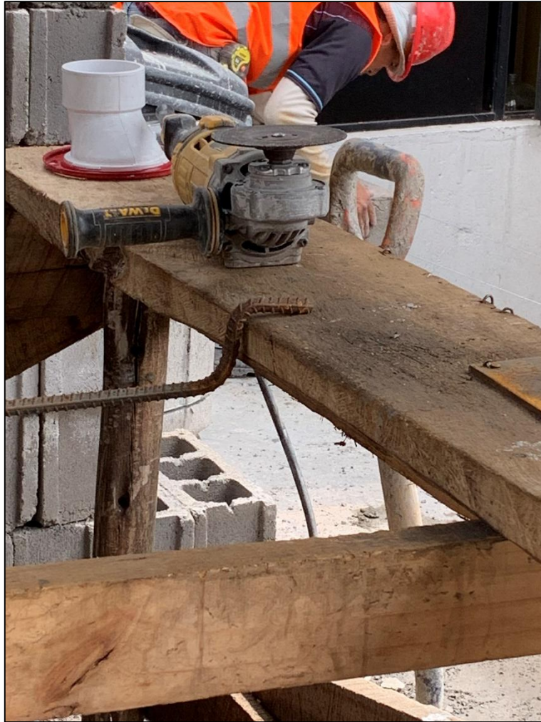
Falta de seguridad en la cortadora. Elaborado por: Fernández Peralta Jorge Luis
