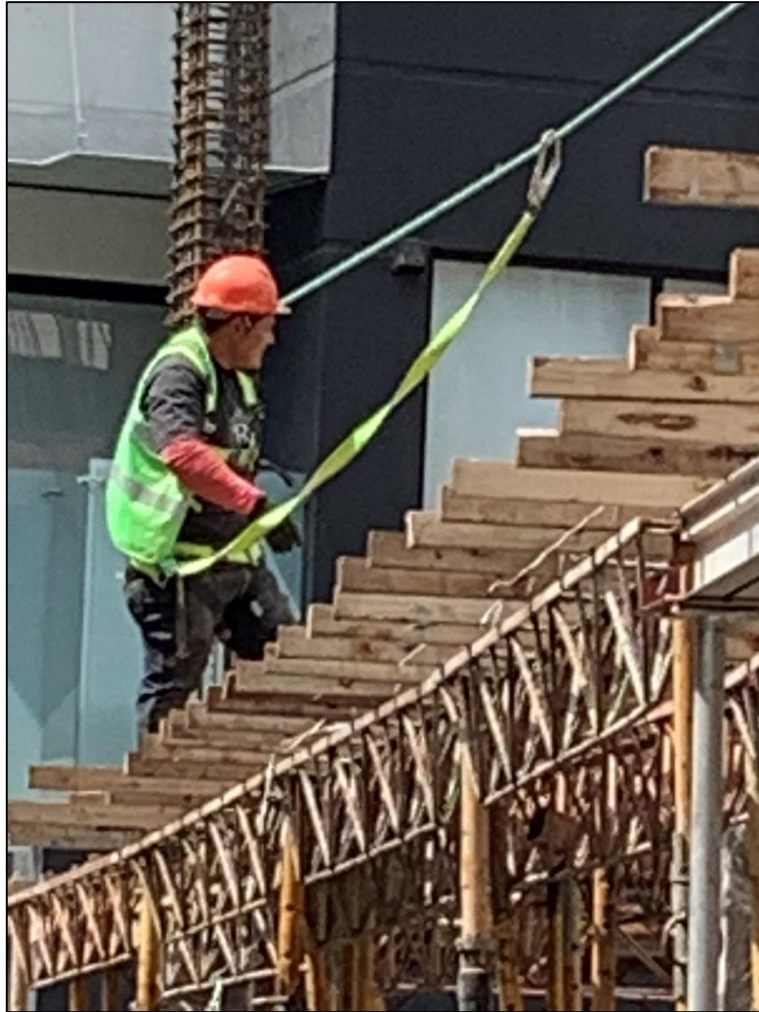
Línea de vida y seguridad para trabajo en alturas con arnés. Elaborado por: Fernández Peralta Jorge Luis
