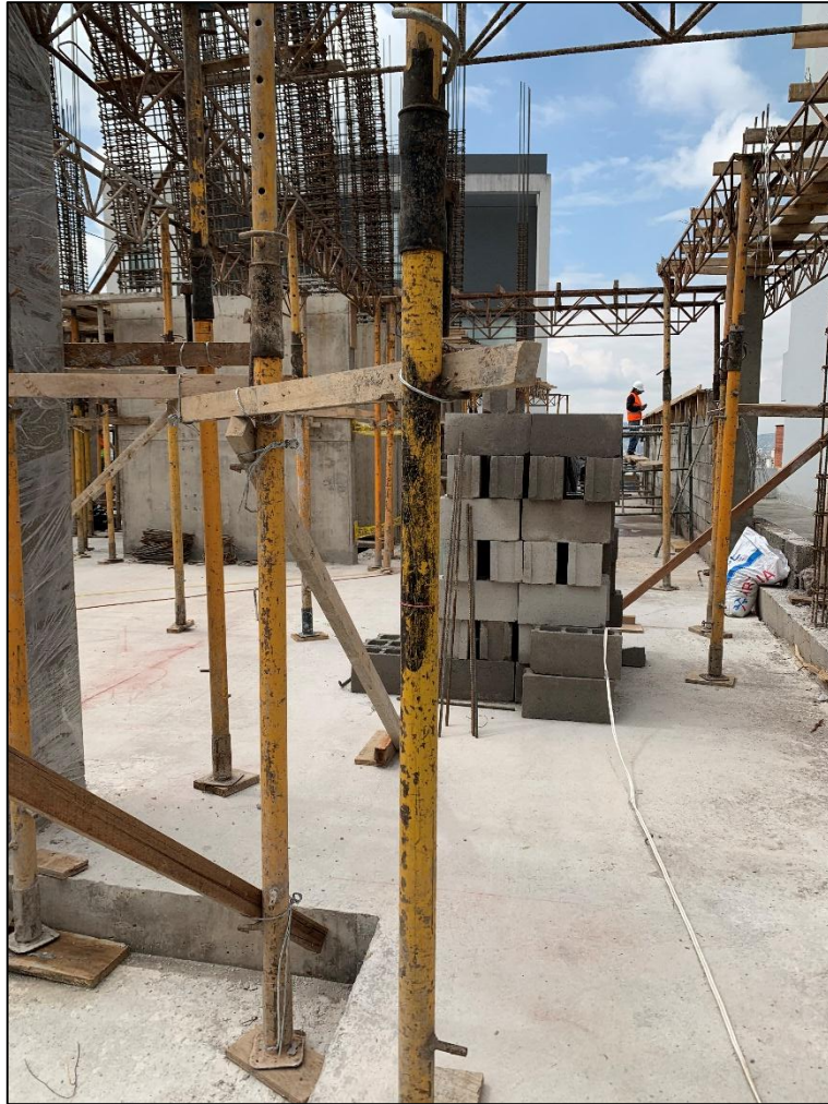
Orden y limpieza dentro de la obra explicado por la constructora. Elaborado por: Fernández Peralta Jorge Luis
