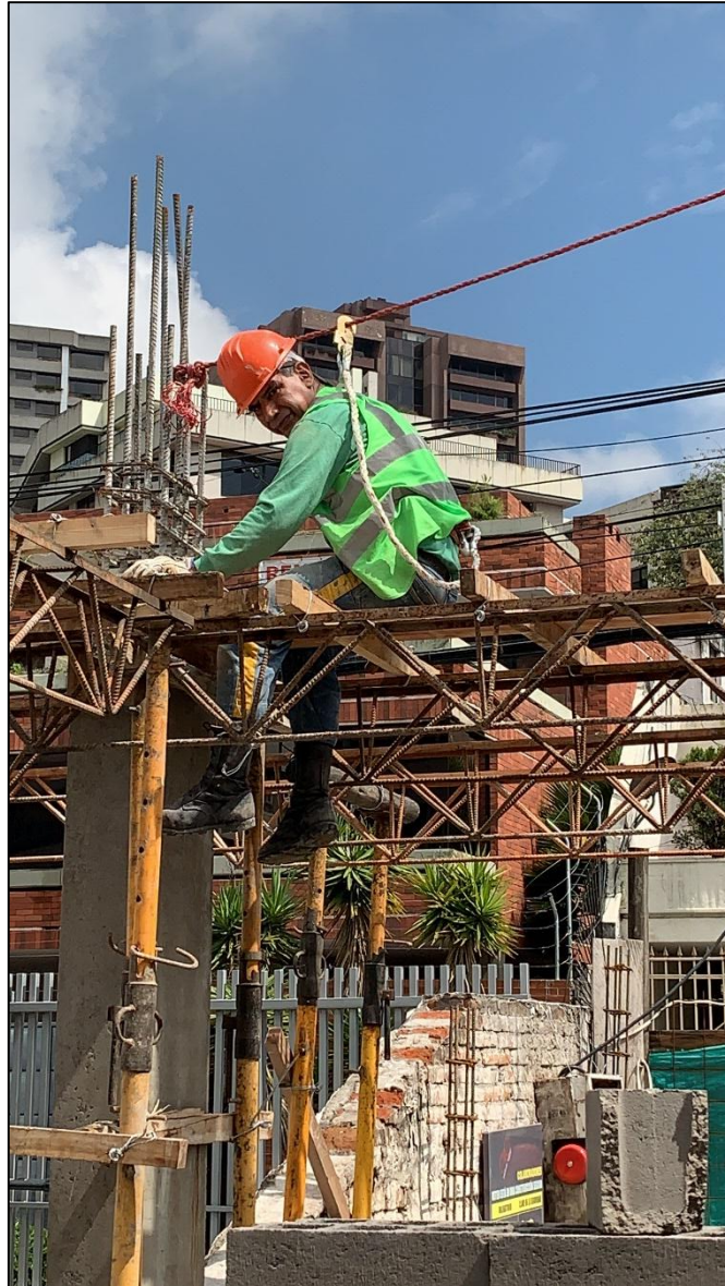
Línea de vida y seguridad para trabajo en alturas con arnés. Elaborado por: Fernández Peralta Jorge Luis
