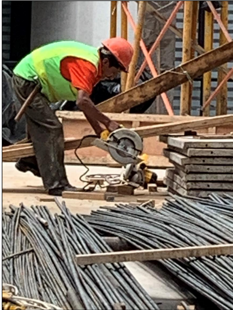
Posible cortes o lesiones con cortadora eléctrica. Elaborado por: Fernández Peralta Jorge Luis
