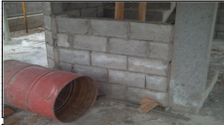
LAS COLUMNAS SE LAS DESENCOFRO 24 HORAS DESPUES DE LA FUNDICION
