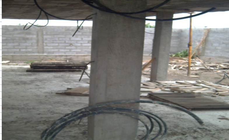
LA MEZCLA SE LA REALIZO A MANO, EL TIEMPO EMPLEADO EN LA FUNDICION FUE DE 35 MIN POR COLUMNA APROX.
