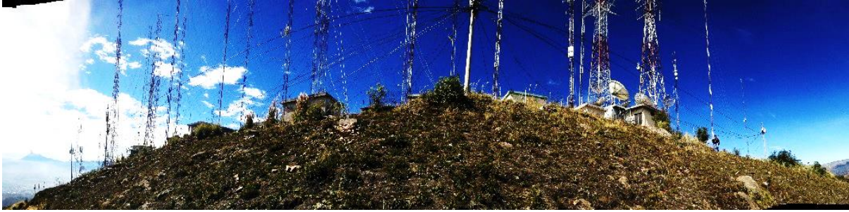
Figura 5.2-23 Transmisores y antenas en cerro Hignug-Cacha que demuestra alta densidad.
