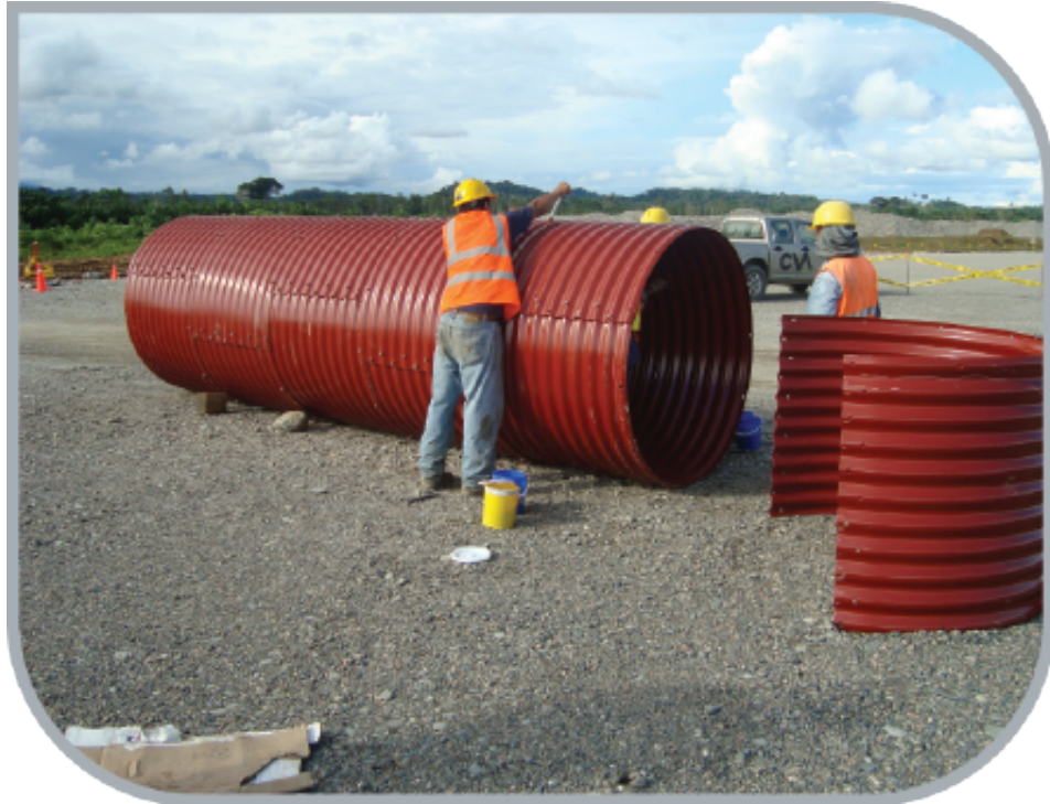
Nuevo Aeropuerto del Tena 2010
