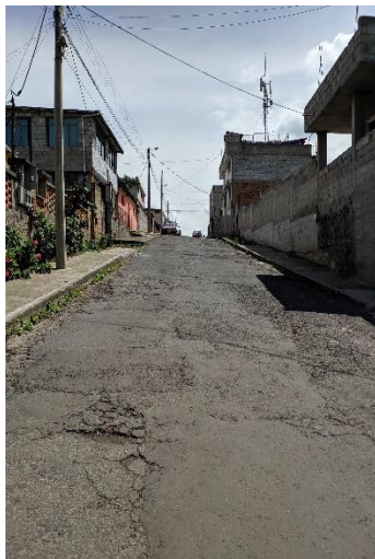
Calle México – Segmento Asfaltado
