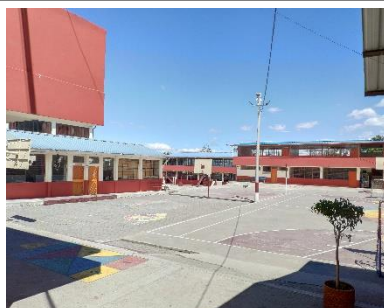
Equipamiento de Educación. Colegio Pedro Luis Calero
