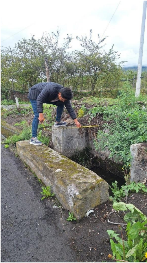
Toma de medidas de alcantarillas.
