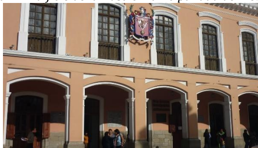
Figura 11. Edificio de la Ilustre Municipalidad de Riobamba
