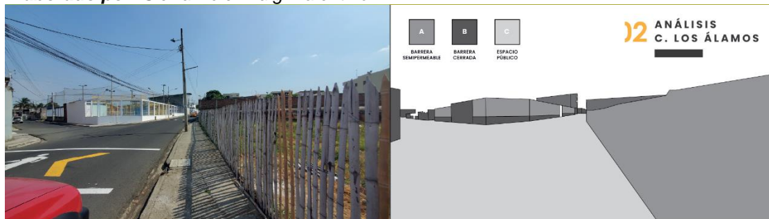
Ilustración 21: Réplica de muro ciego por presencia de urbanizaciones cerradas, Caso 2. Elaborado por: Sierra Vélez Luigi Valentino
