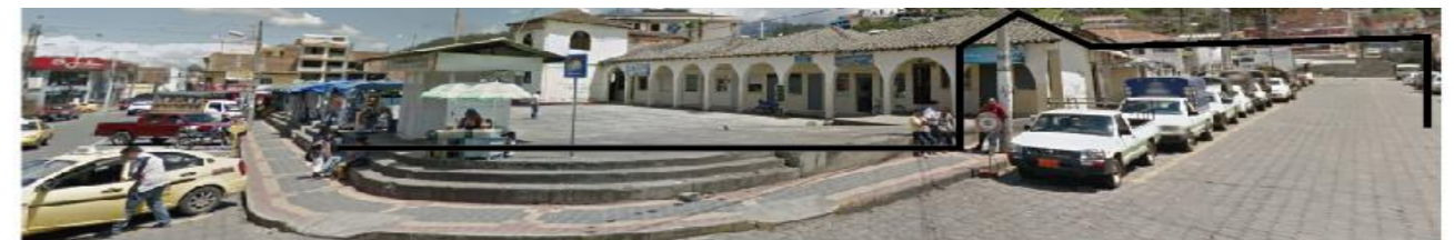
FACHADA CALLE JUAN MONTALVO MERCADO COPACABANA ESTADO ACTUAL
