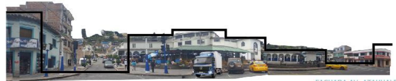
FACHADA AV. ATAHUALPA MERCADO COPACABANA ESTADO ACTUAL
