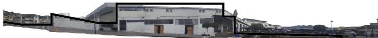
FACHADA AV. ABDÓN CALDERÓN MERCADO COPACABANA ESTADO ACTUAL
