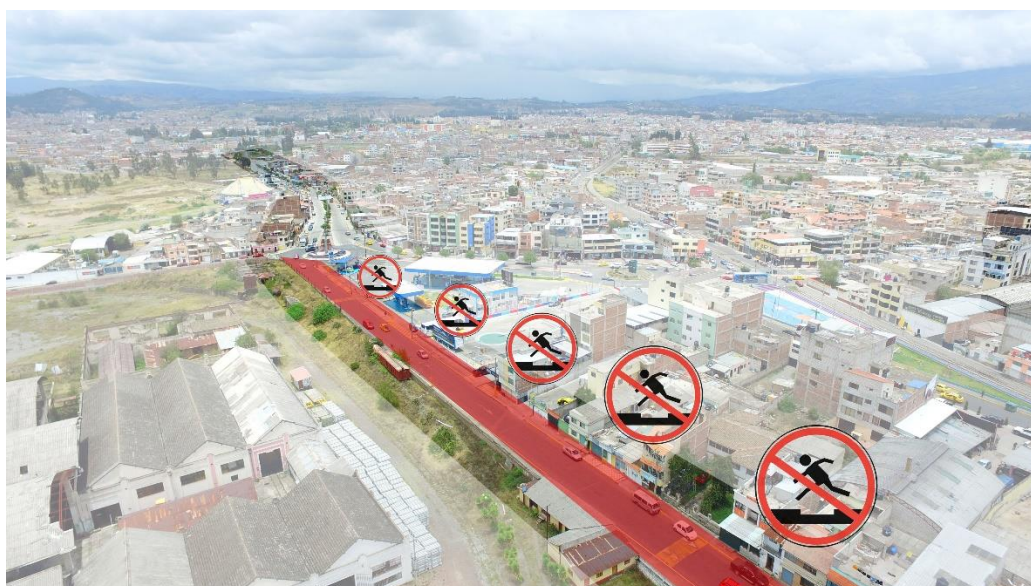
Figura 22. Vía rápida en el ingreso principal a los talleres del ferrocarril, limitante para la permeabilidad del espacio, Riobamba (2022)
