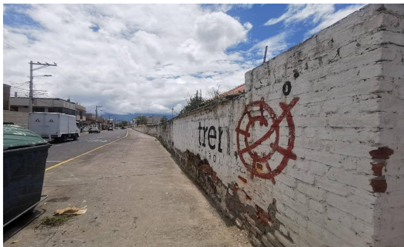
Figura 21. Cerramiento perimetral de la estación del ferrocarril Riobamba (2022)
