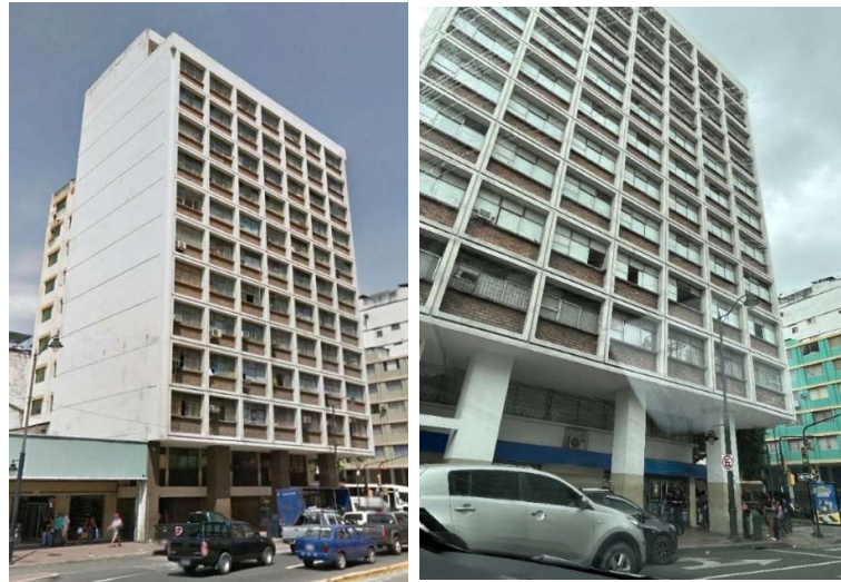
Ilustración 62 Imágenes de 2015 (Google, 2015)– 2023 (Imagen tomada por el autor) Edificio en la esquina Eloy Alfaro y Colón, se encuentra deshabitado, a excepción de la planta baja comercial, y con degradación estructural ocasionada por los temblores
