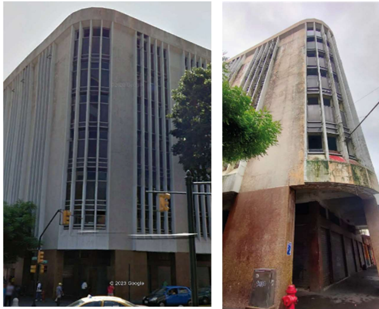
Ilustración 21 Edificios en proceso de abandono 2015- 2023. Esquina Aguirre y Pedro Carbo Fuente: Fotografías tomadas por el Autor (Google, 2015)
