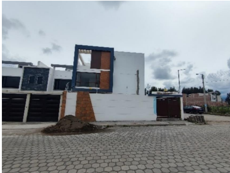
Ilustración 5: Fachada calle Benjamín Carrión
