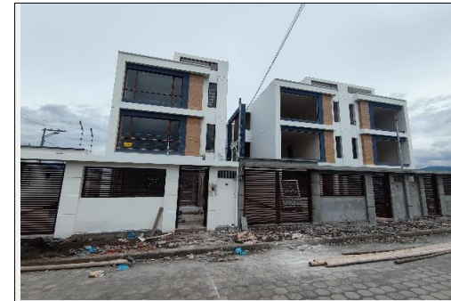
FACHADA FRONTAL DEL BIEN INMUEBLE
