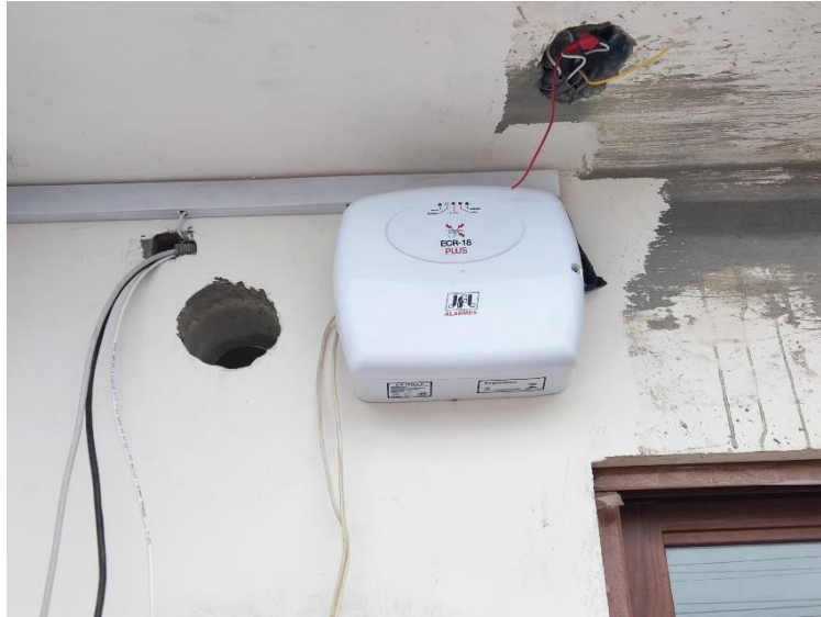
Ilustración 9: Alarma de seguridad
