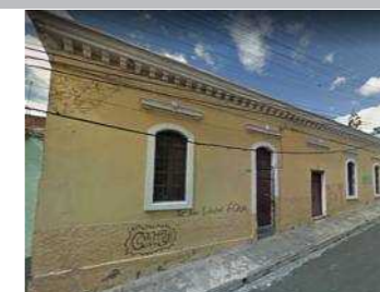
Vivienda Patrimonial - Calle Sincholagua Fuente.: Google Maps
