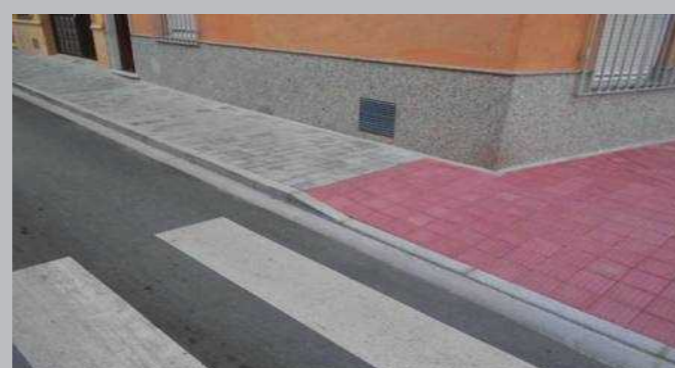
Acera con adoquines sin Obstáculos Fuente:https://www.prefabricadosjara.com/
