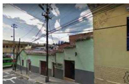
Postes en mitad de acera - Calle Sincholagua Fuente.: Google Maps
