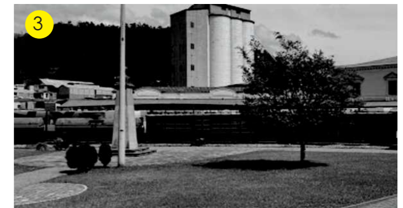
ESTACIÓN DE TRENES CHIMACALLE Fuente: Google Maps (2023)
