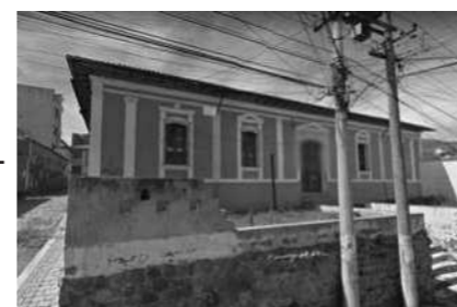
Edificación Republicana de Chimbacalle Fuente: Google Maps (2023)
