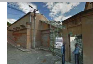
Fachada del MIC - Calle Tababela Fuente.: Google Maps
