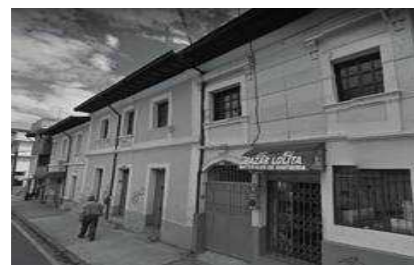
Edificación Republicana de Chimbacalle Fuente: Google Maps (2023)
