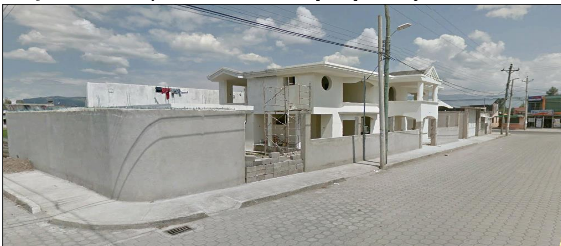
Fotografía No. 9. Se aprecia la construcción de una vivienda, las viviendas localizadas en Rumiloma poseen función residencial (Francisco Méndez, Marzo 2017).
